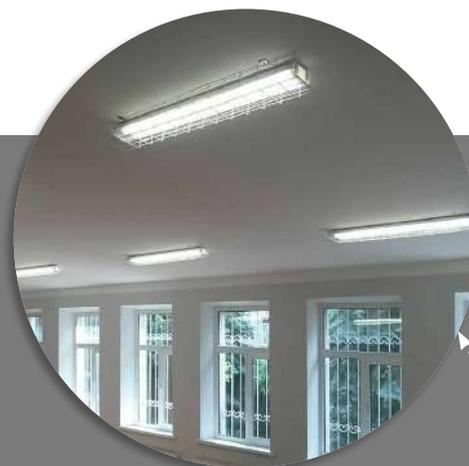
Решетка защитная для линейных светильников служит для надежной защиты рассеивателей светильников от механических повреждений и попадания посторонних предметов. Идеально подойдет для установки в спортзалах, на складах, производствах, парковках и пр.
